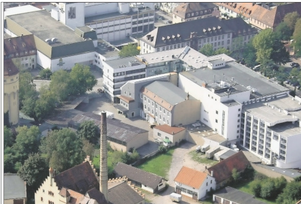
Die nächste Etappe für die Entwicklung des Schneider-Hatz-Areals steht bevor. Am Montag soll der Gemeinderat den Bebauungsplan auf den weiteren Weg bringen. Foto: W. Walter
