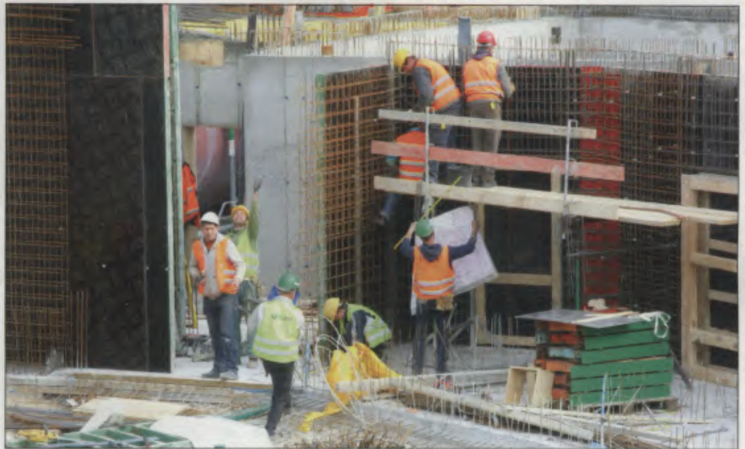
Hochbetrieb auf der Baustelle SchlossGalerie: Im Schnitt arbeiten dort täglich rund 80 Menschen.
