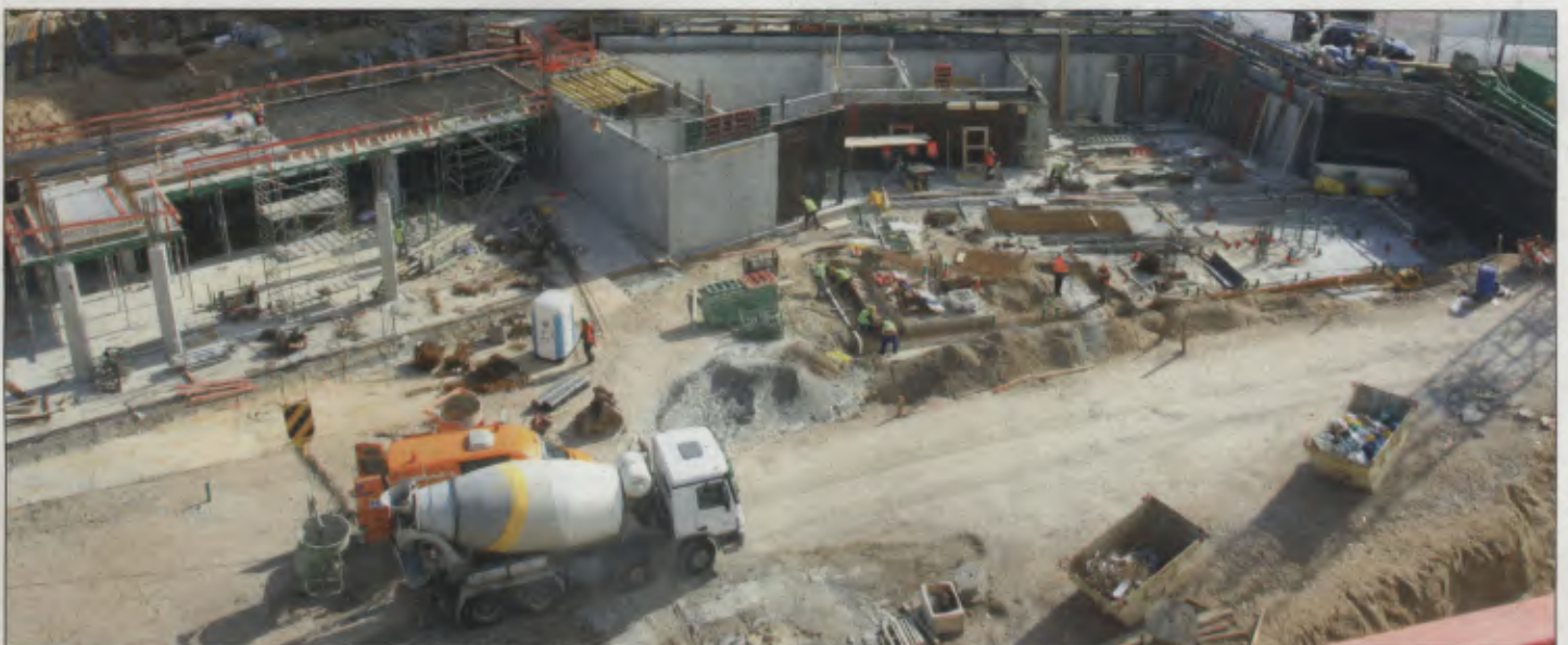
Blick auf die Baustelle von der dritten Etage des ehemaligen Schneider-Kaufhauses in Richtung Pagodenburg. Die Arbeiter sind auf der riesigen Fläche kaum zu erkennen.
