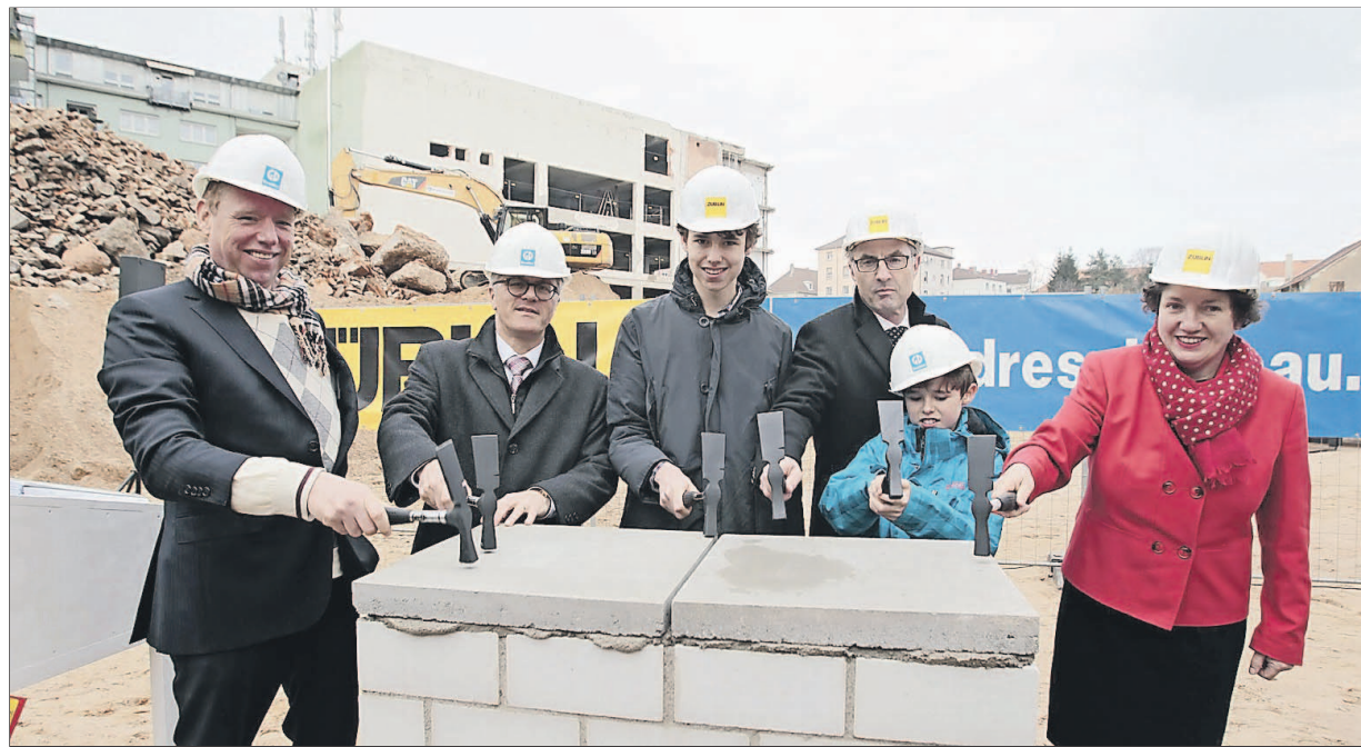
Mauern Tageszeitungen, eine Urkunde, Projektinformationen und Münzen im Grundstein ein: Vertreter der Investorenfamilie mit Cor Blatt (links) an der Spitze, OB Pütsch (Zweiter von links), Züblin-Direktionsleiter Gerald Lanzenberger (Vierter von links) und Projektentwicklerin Brigitte van der Jagt.
