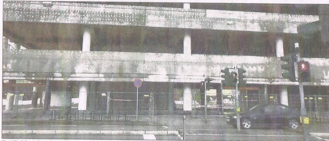
Der Rohbau des einstigen Kaufhauses Schneider soll bald sein Gesicht verändern.
