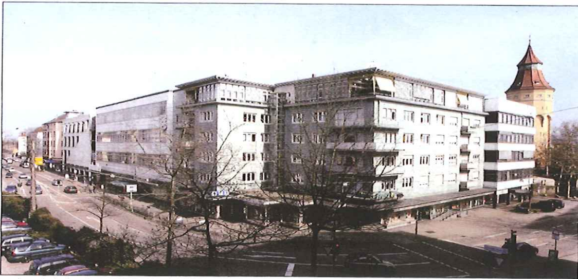
In der Bahnhofstraße ist die ganz große Lösung geplant: Nach RAZ-Informationen sollen das Parkhaus abgerissen und das Schneider-Gebäude vollständig entkernt werden. Auch das Hatz-Verwaltungsgebäude (rechts) in der Kapellenstraße muss weichen, wenn das Projekt der Kroon Group Germany umgesetzt wird. Fotos: schauppel-pr / Gerhard
